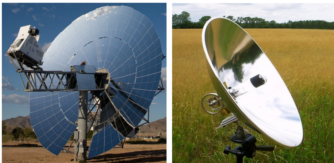
Рисунок 2.3 – Солнечный концентратор с двигателем Стирлинга
